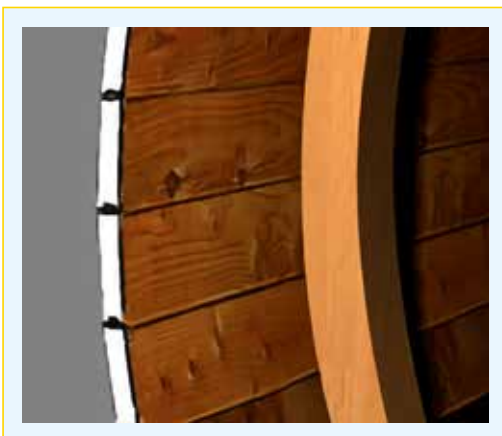
● Ryc. nr 47. Poszycie stykowe. Źródło: Wikipedia, Poszycie stykowe , https://pl.wikipedia.org/wiki/Poszycie_stykowe [dostęp: 7.02.2021 r.].
