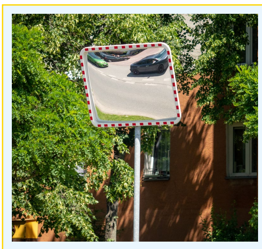
● Fot. 14. Zastosowanie lustra drogowego wypukłego U-18b.
