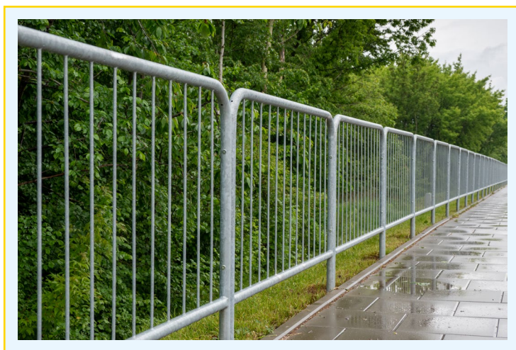
● Fot. 7. Balustrada U-11a zastosowana w celu zabezpieczenia pieszych przed spadnięciem z nasypu.
