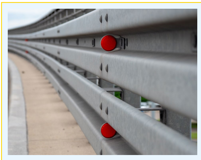
Fot. 2. Przykład punktowych elementów odblaskowych U-1c umieszczanych na barierze ochronnej.
