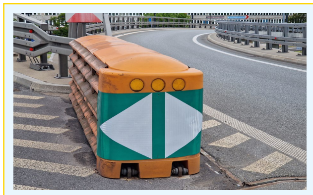
● Fot. 10. Przykład zastosowania osłony energochłonnej U-15a.
