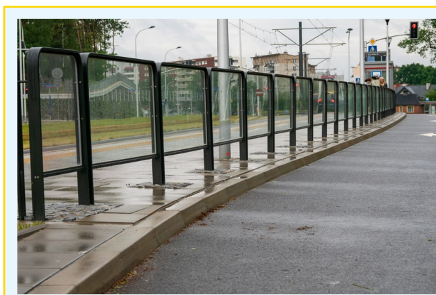
Fot. 8. Ogrodzenie segmentowe U-12a oddzielające pieszych od jezdni przy przystanku tramwajowym.
