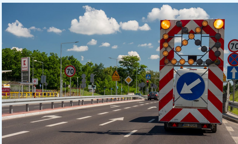
● Fot. 16. Zastosowanie tablicy zamykającej w związku z prowadzonymi robotami drogowymi.
