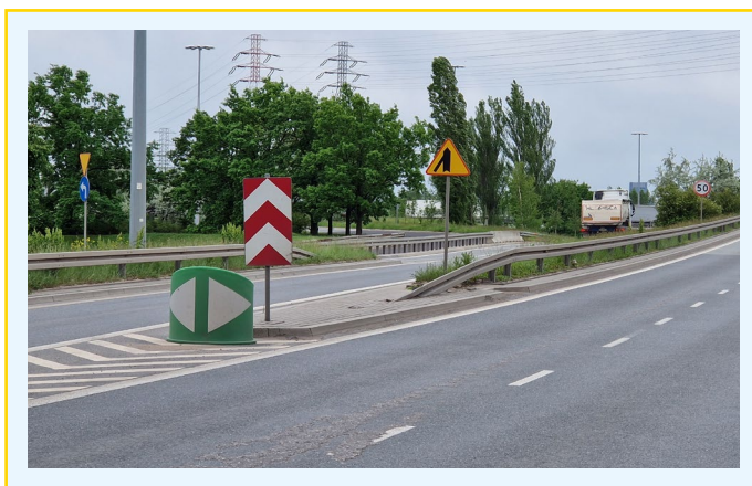
● Fot. 11. Osłona zabezpieczająca U-15b zastosowana wraz z tablicą rozdzielającą U-4a.
