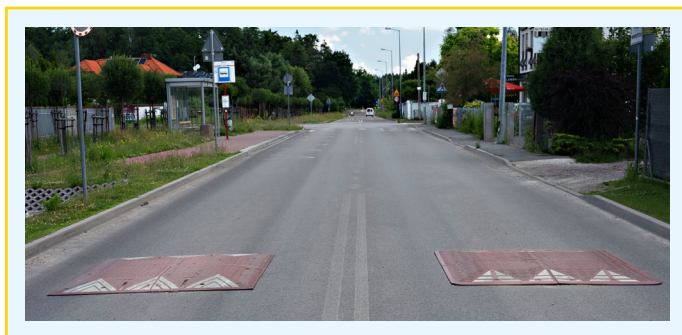
Fot. 12. Przykład zastosowania i oznakowania progów wyspowych.
