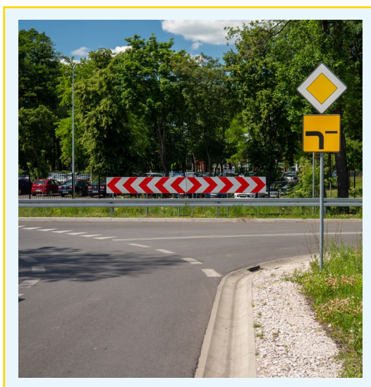
Fot. 4. Tablice prowadzące ciągłe U-3c i U-3d uprzedzające kierującego o koniecznej zmianie kierunku jazdy na skrzyżowaniu.
