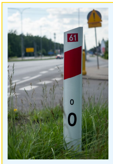
Fot. 1. Słupek prowadzący umieszczony samodzielnie na poboczu.
