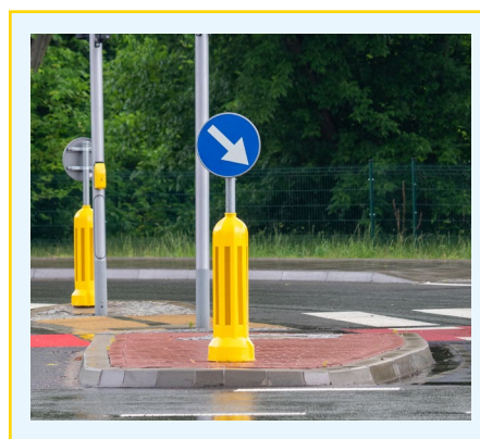
Fot. 5. Słupek przeszkodowy U-5a z umieszczonym nad nim znakiem C-9.
