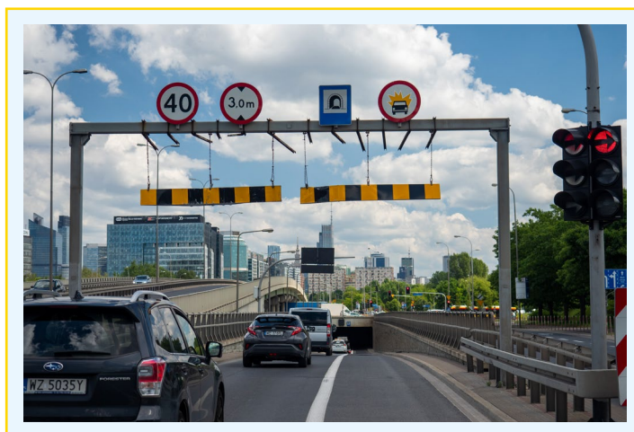
Fot. 6. Przykład zestawienia urządzeń bramowych U-10b przy wjeździe do tunelu.
