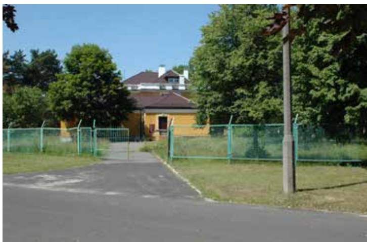
Zdjęcie 21. Miejsce zdarzenia wraz z terenem przyległym
